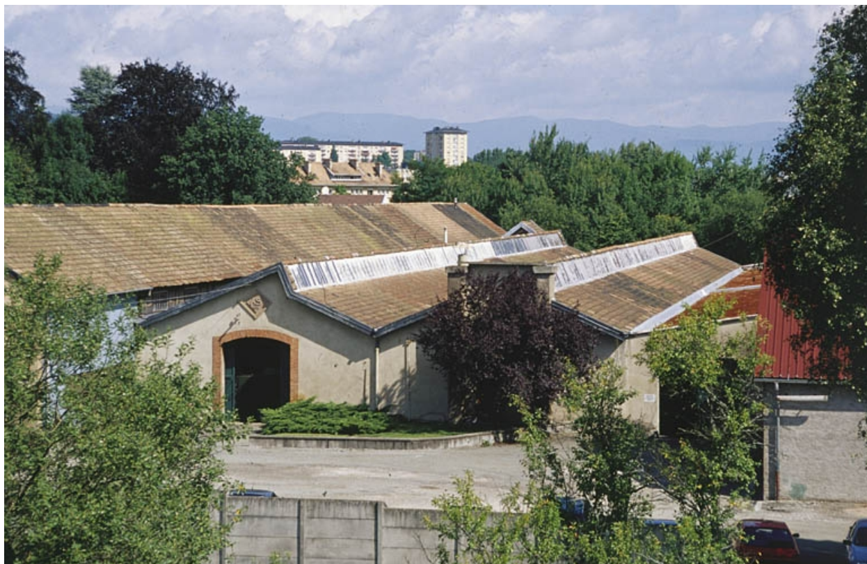
Ateliers de fabrication depuis le sud.
