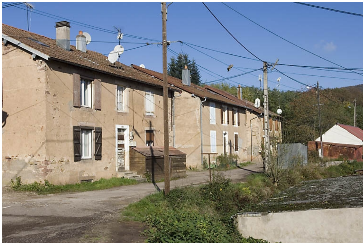
Façades sur rue des maisons d'ouvriers.
