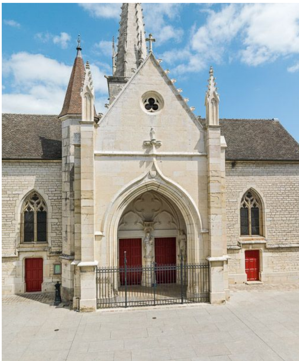
Vue d'ensemble de la façade ouest.
