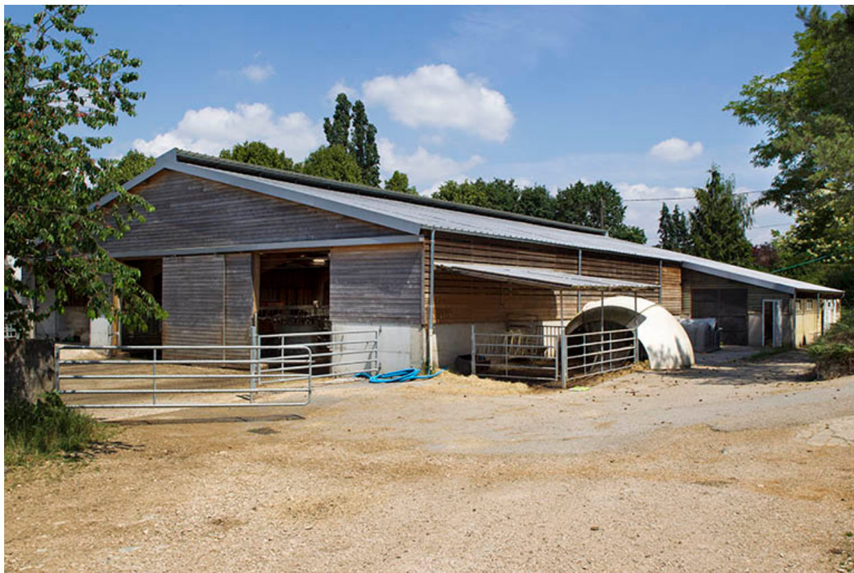
L'étable ouest vue de trois-quart sud-est.
