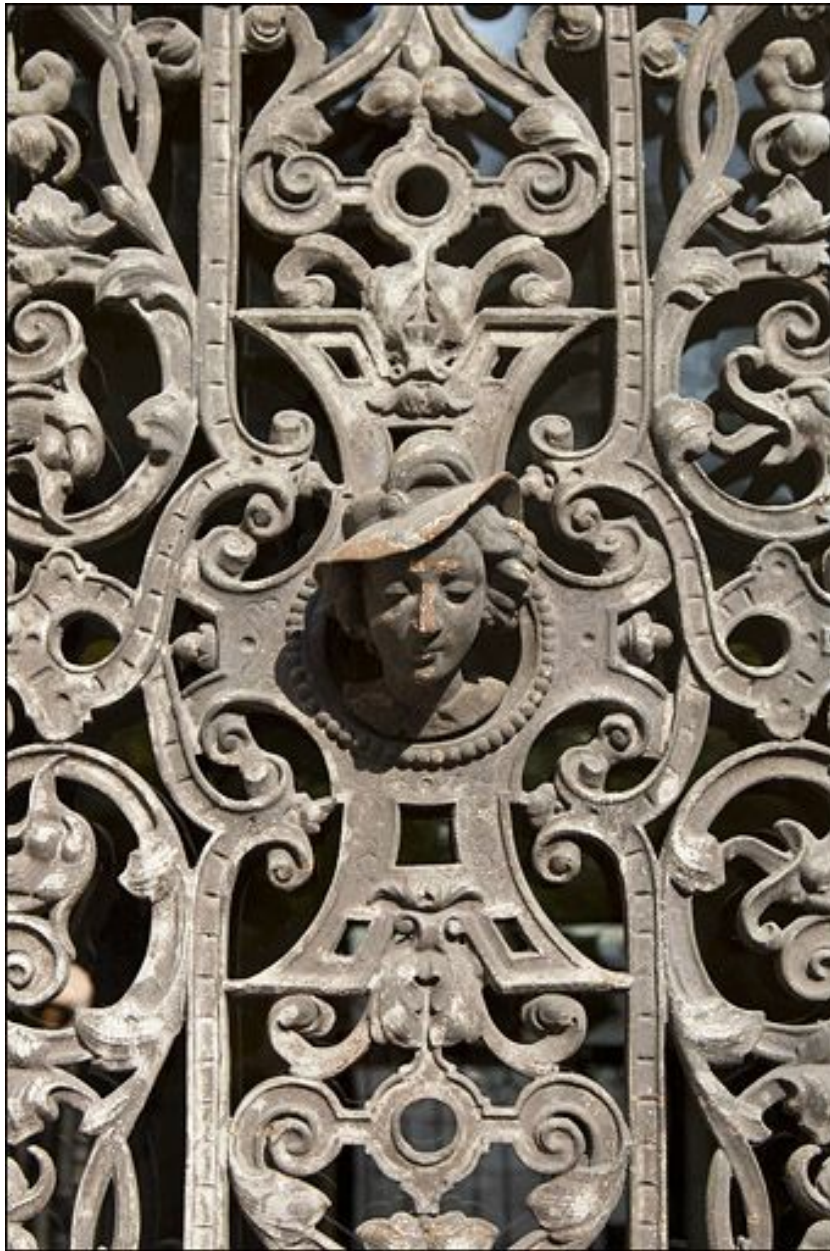
Détail du décor en fonte d'un des panneaux de la porte d'entrée.
