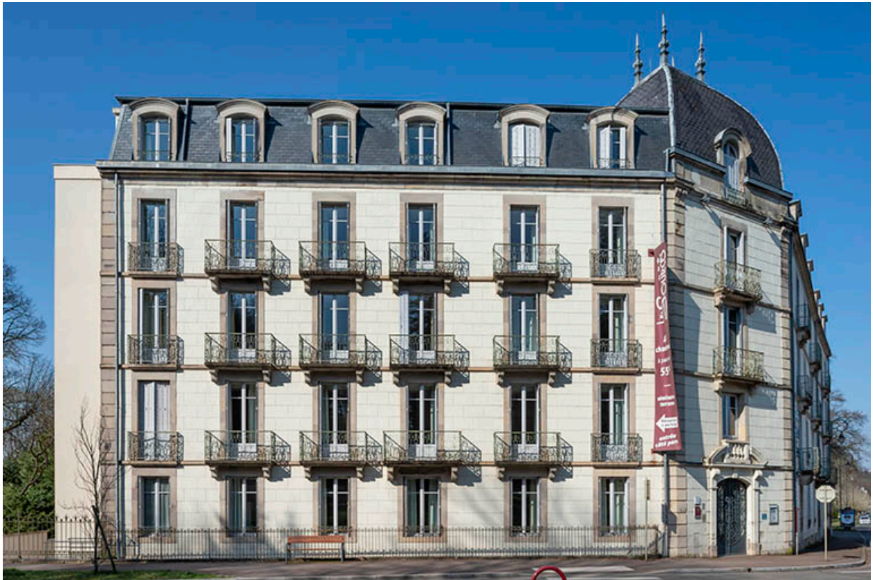
Façade sur rue de l'aile sud.
