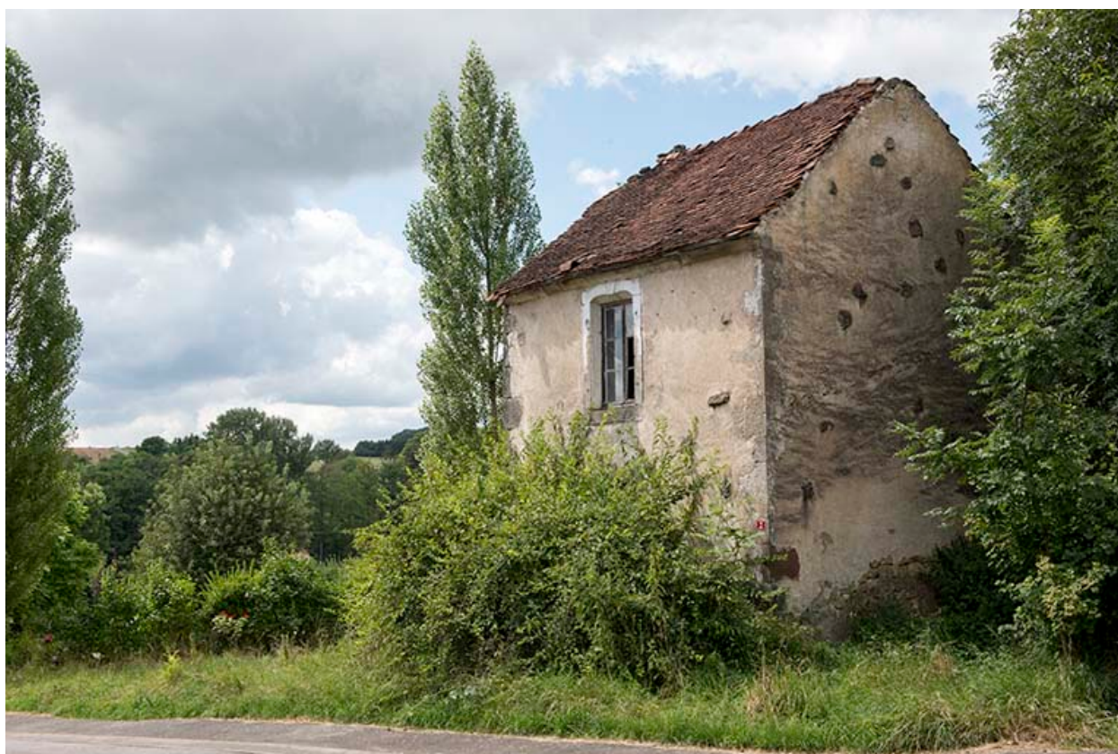
maison 2 rue du moulin
