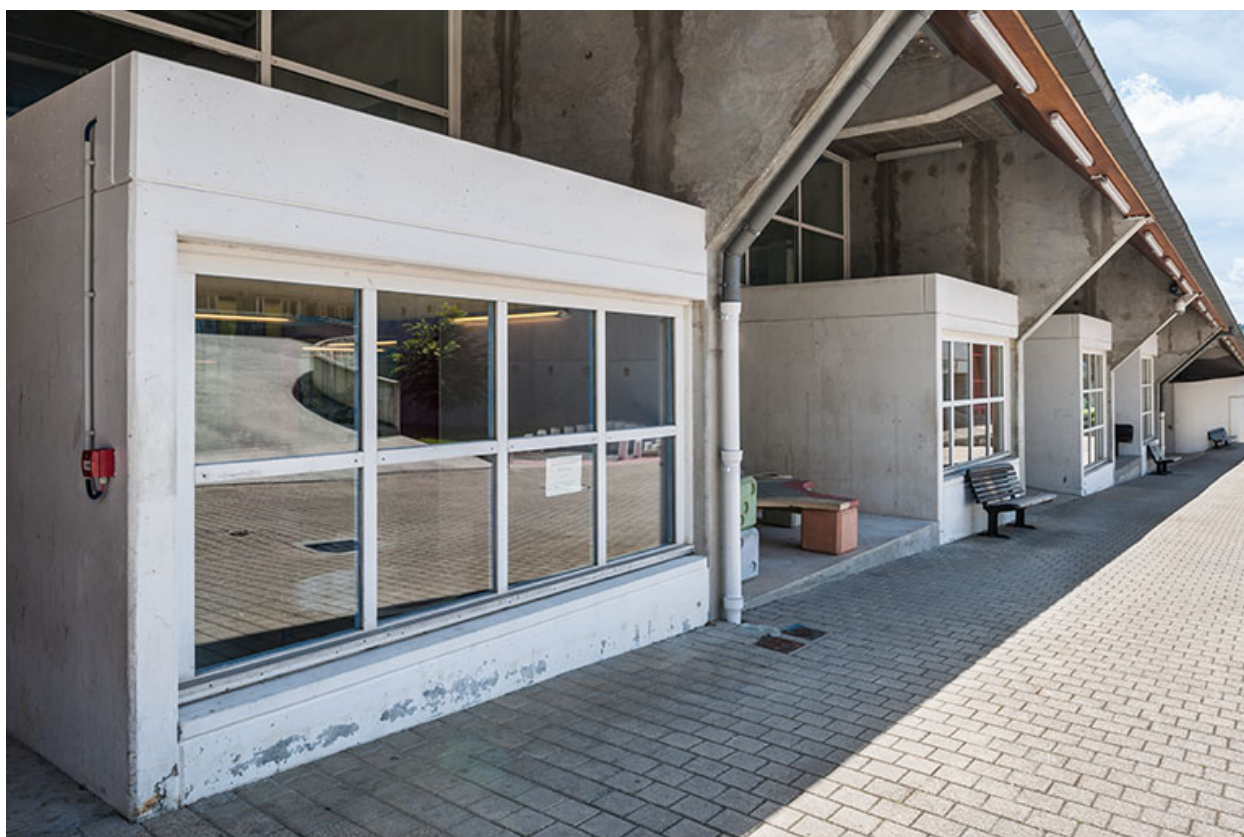
Façade en rez-de chaussée du bâtiment internat-administration
