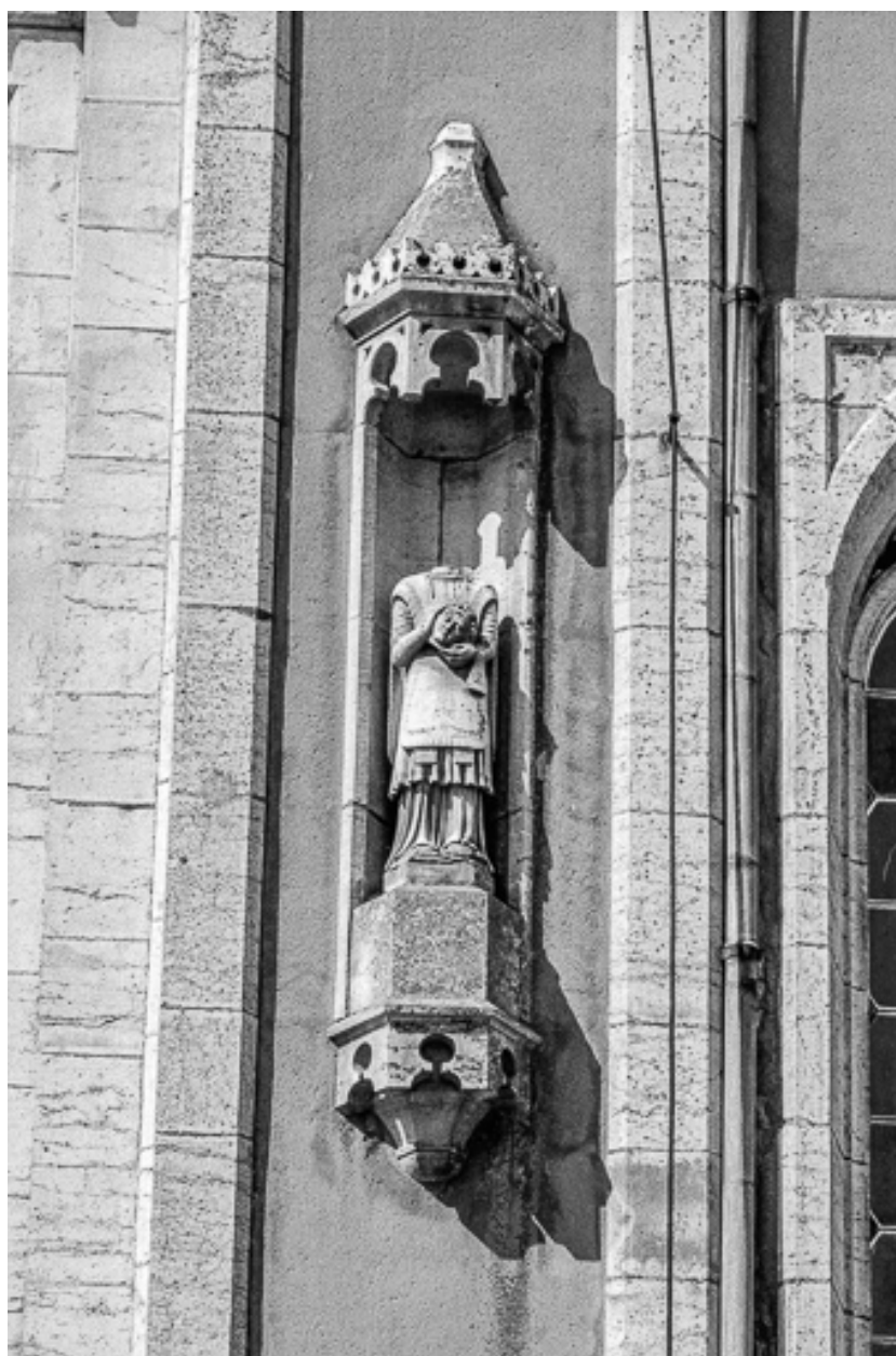
Détail de la tour-clocher : saint Ferréol.
