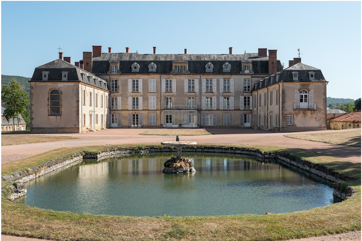
Façade sur la cour et le bassin, vue de face.
