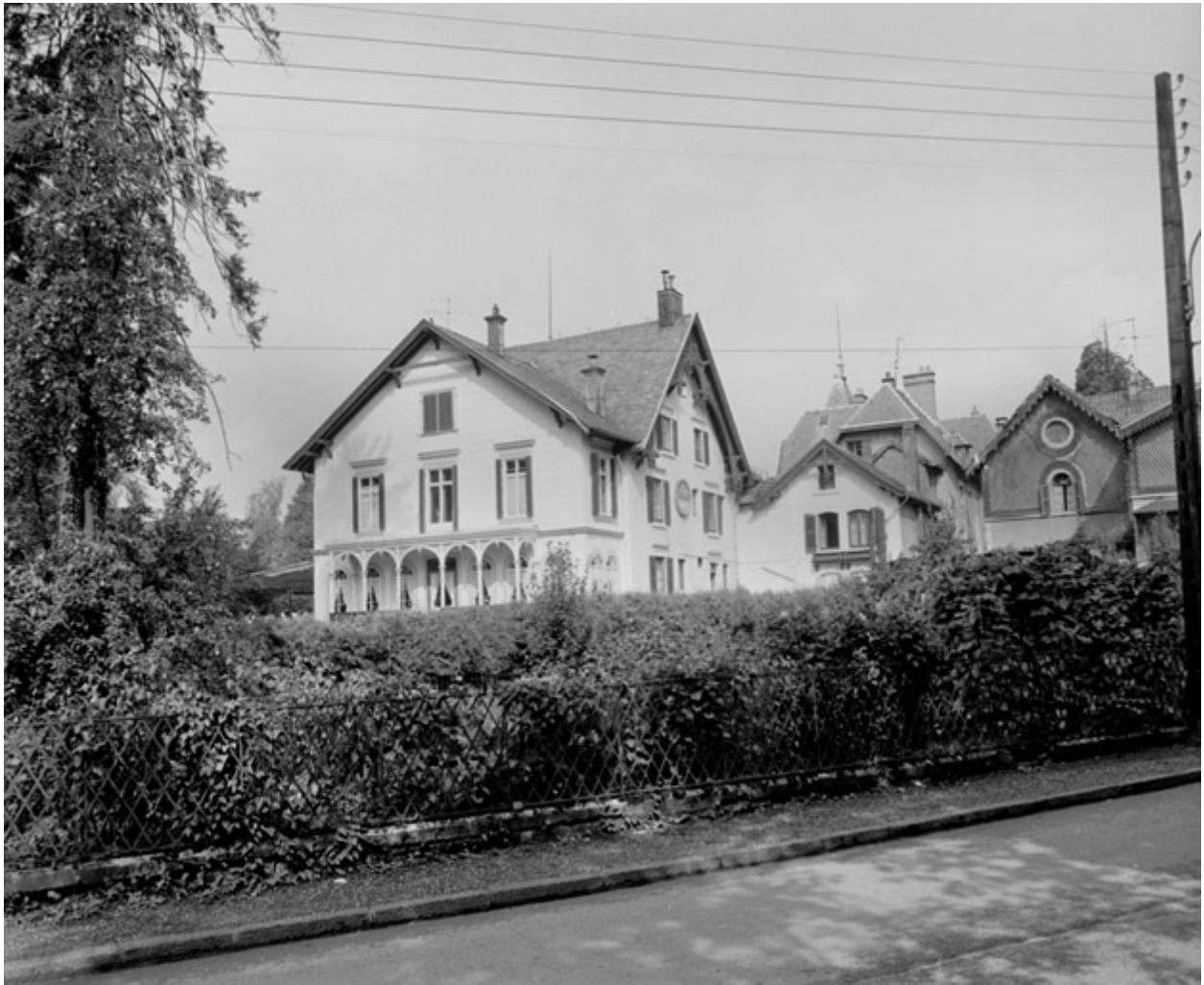
Vue depuis la rue Pierre Sellier en 1981.SRI. Enquête régionale sur les bâtiments industriels (1979-1981).
