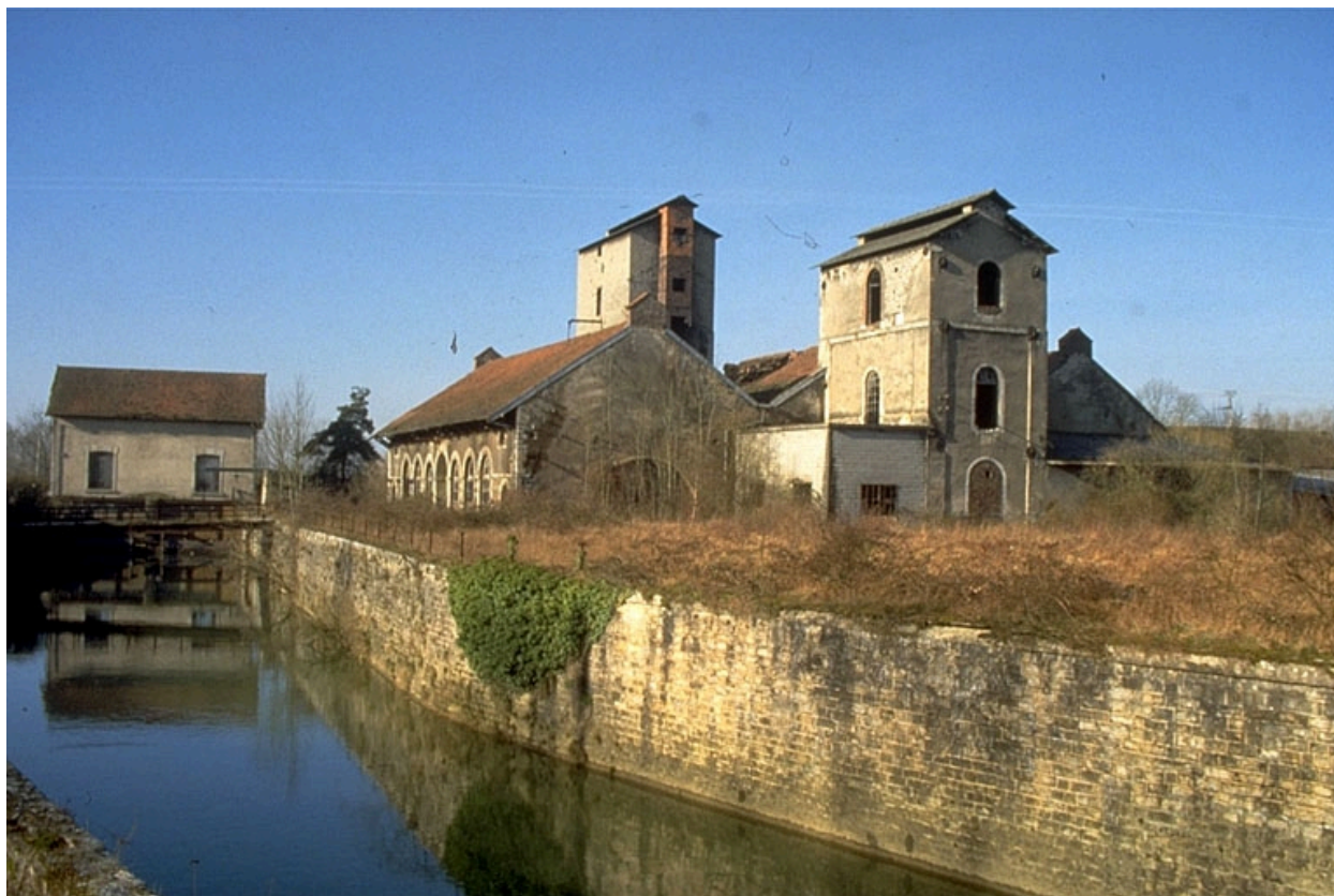
Vue d'ensemble depuis l'est : centrale hydroélectrique (G) et atelier de fabrication (E).
