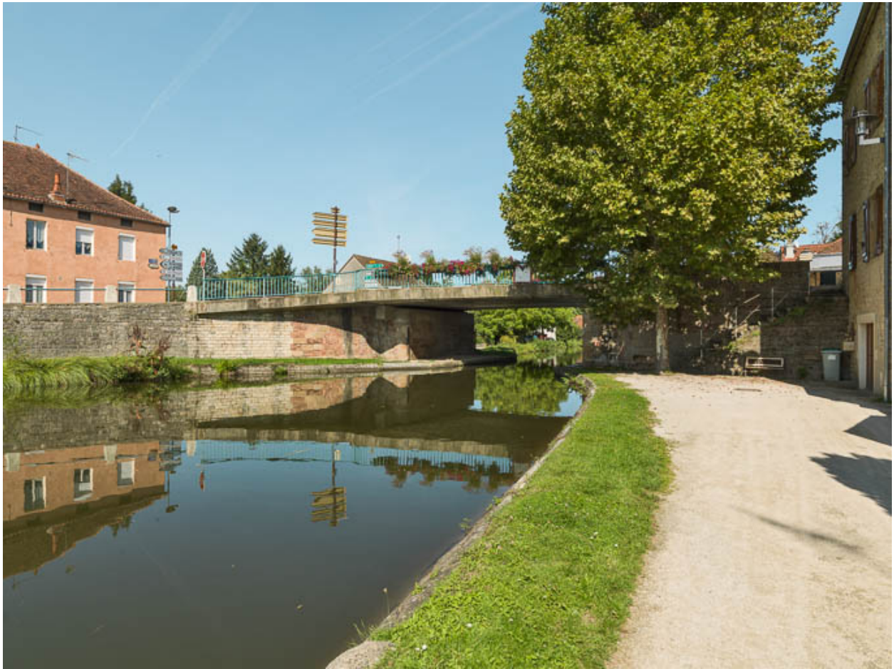
Vue d'ensemble du pont.
