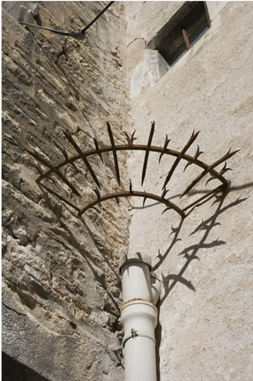
Façade latérale gauche : détail d'un élément horizontal en ferronnerie non identifié.
