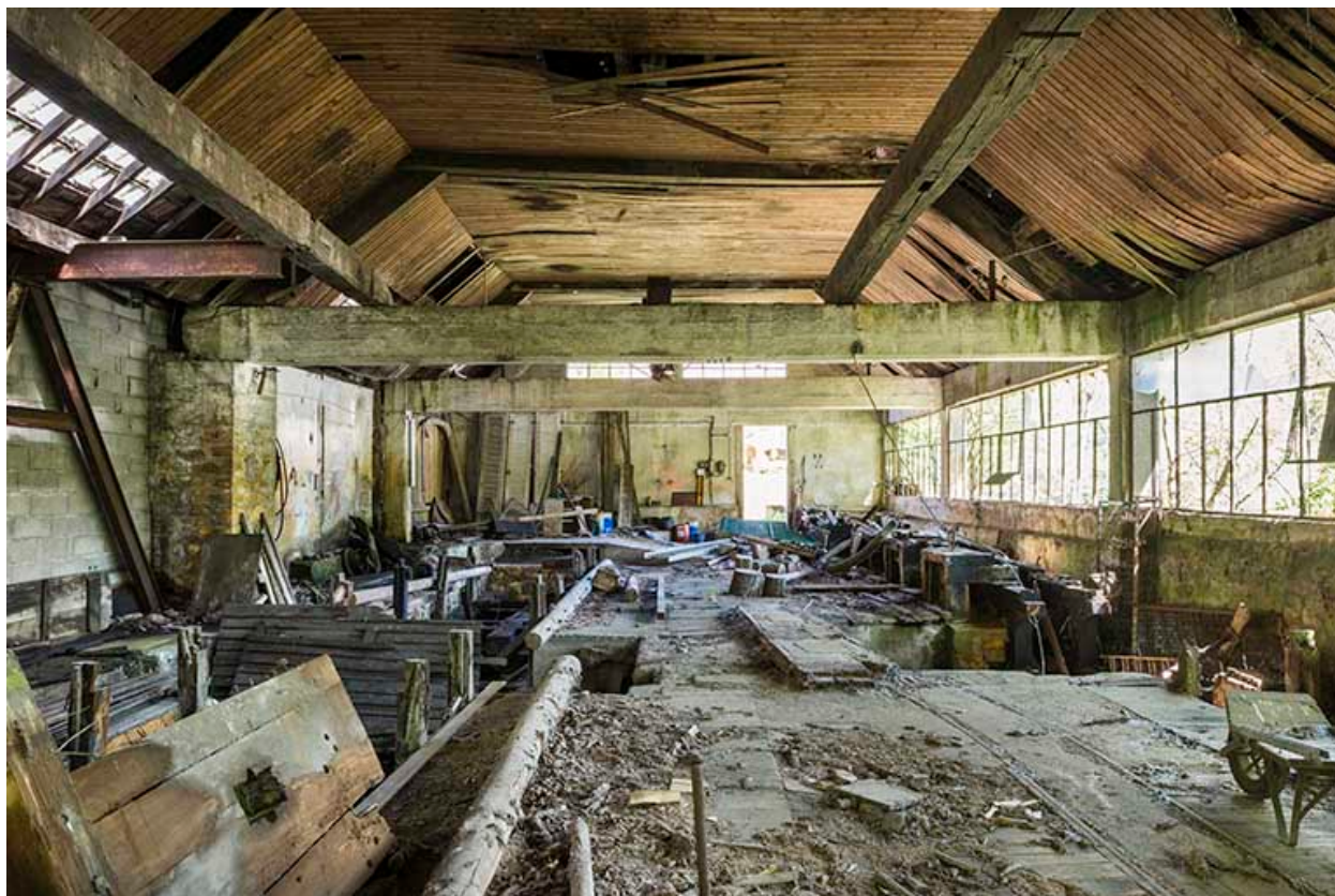
Atelier de tréfilerie. Extrémité est.
