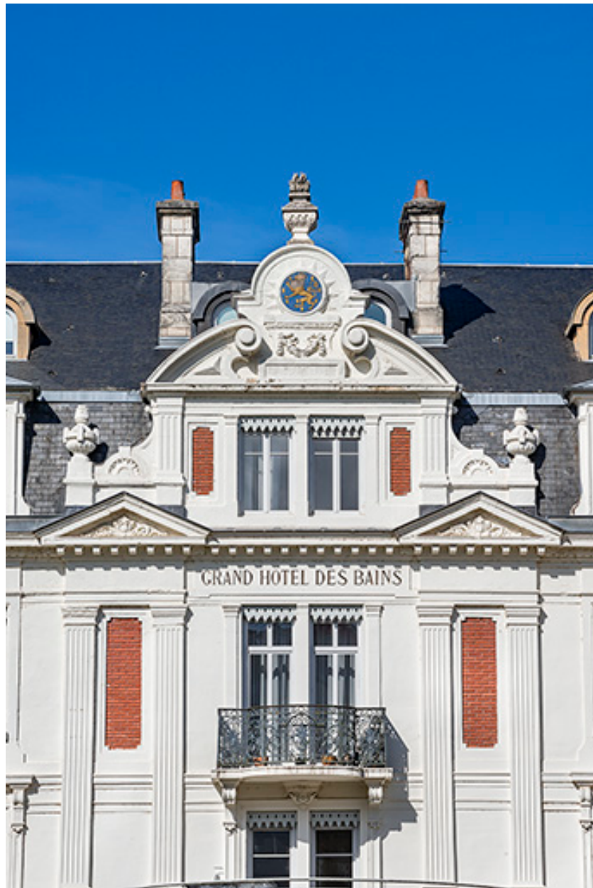
Façade sur le jardin, travées centrales, détail.
