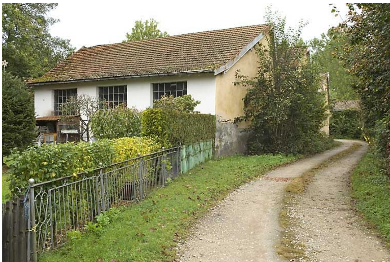
Atelier de fabrication. Vue depuis le sud.
