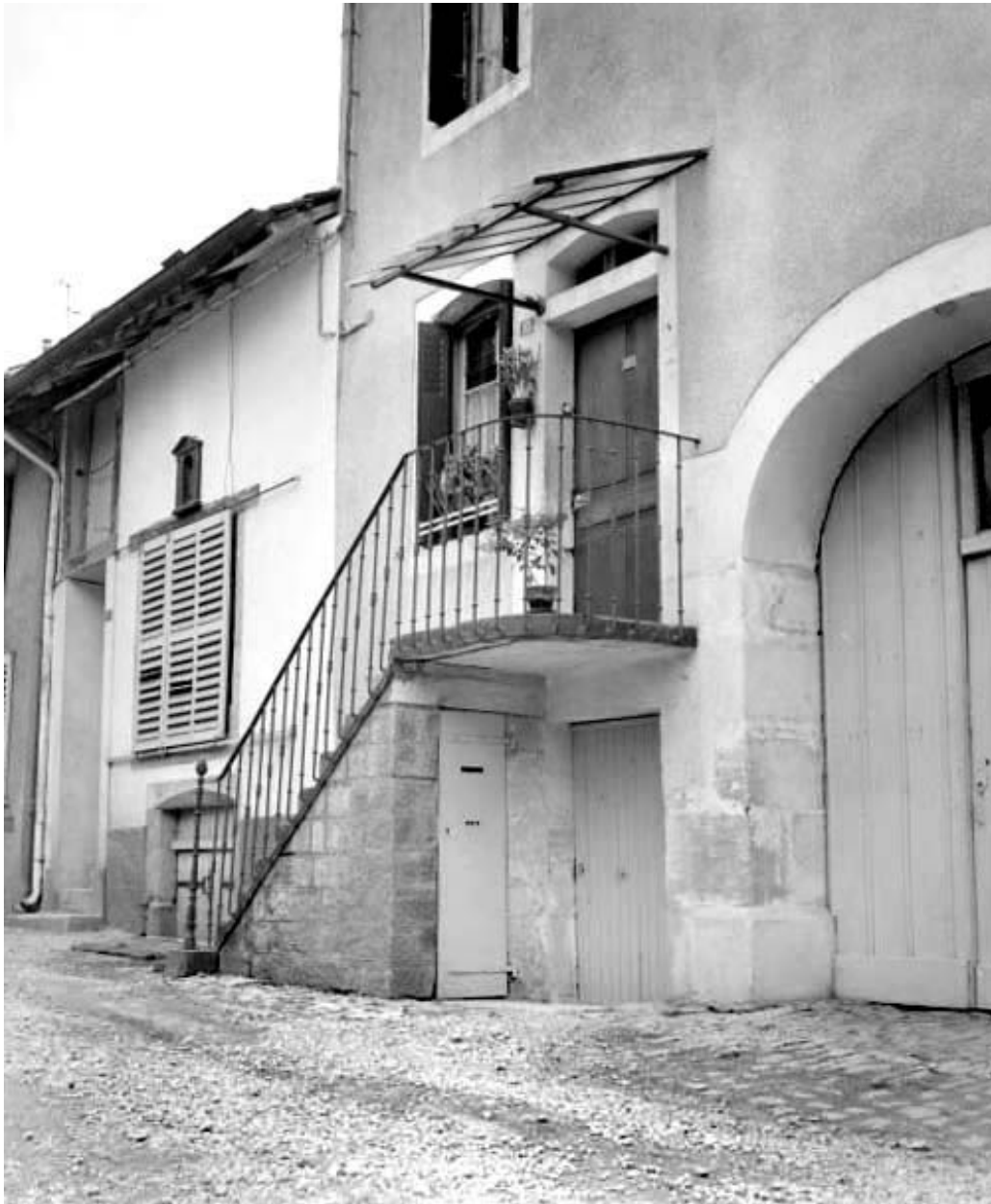
Maison située 13 rue des Martinets.
