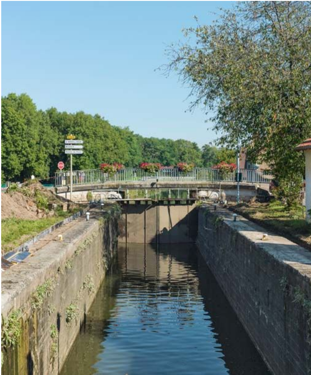
Vue d'ensemble du pont.
