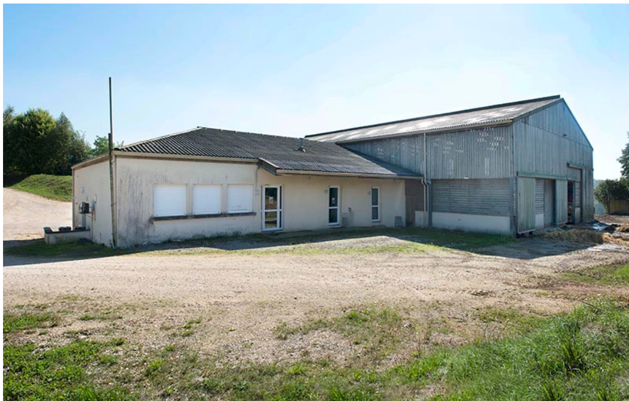
Angle nord-ouest du bâtiment de production laitière.
