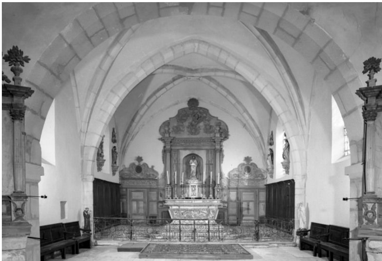
Choeur, vue intérieure
