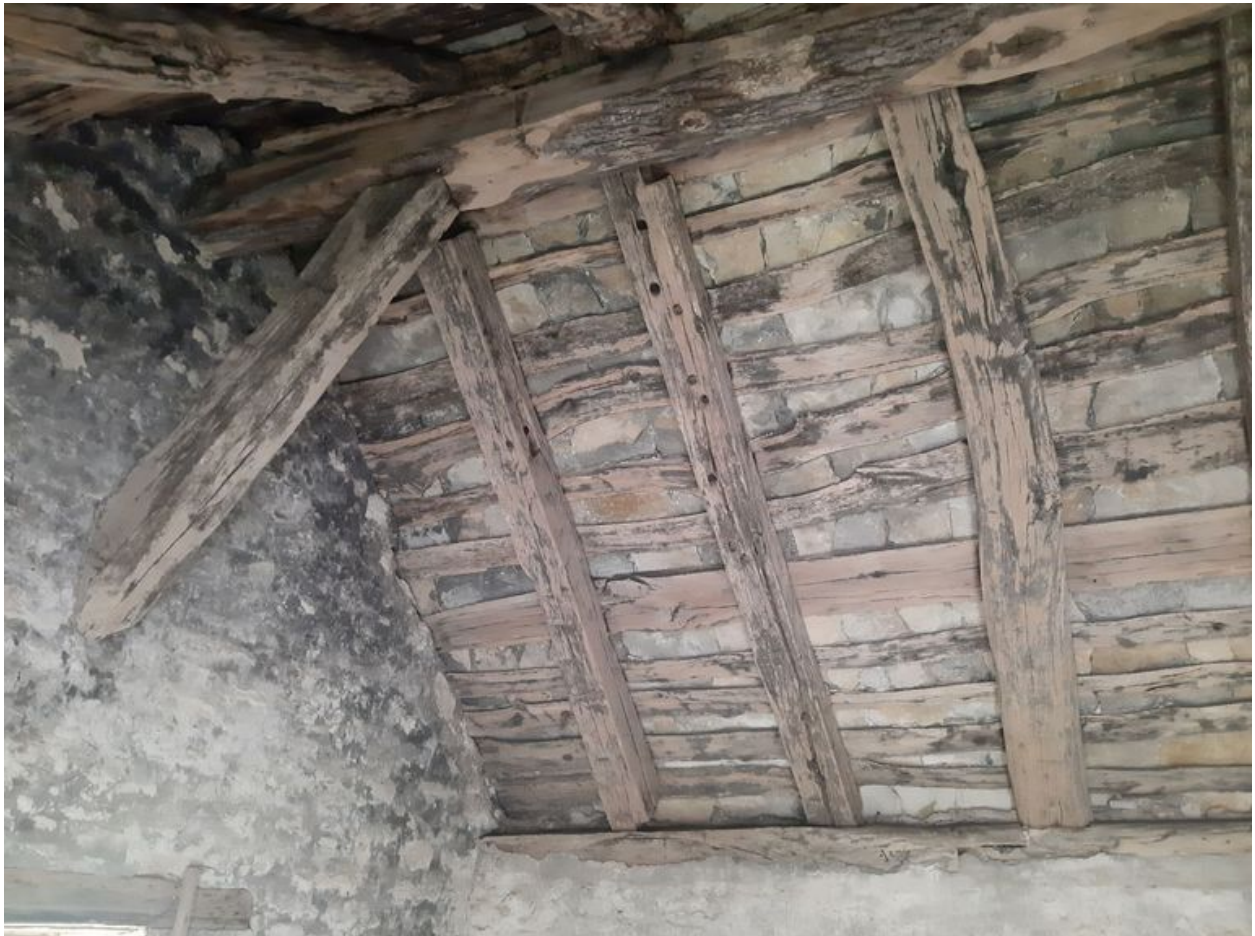
Détail de la charpente et de la sous-face en planches de la couverture en laves.
