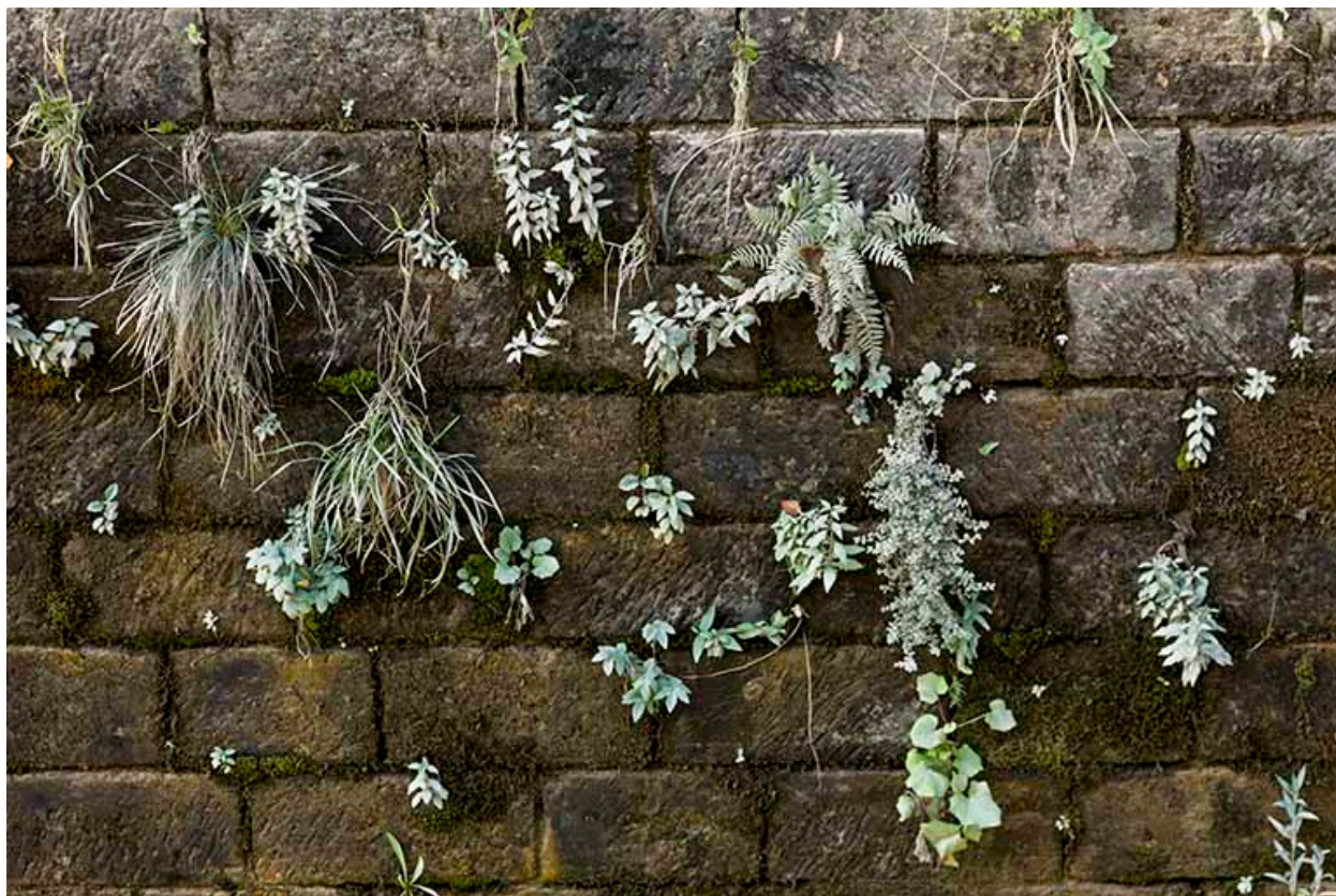
Détail sur la maçonnerie d'une écluse.
