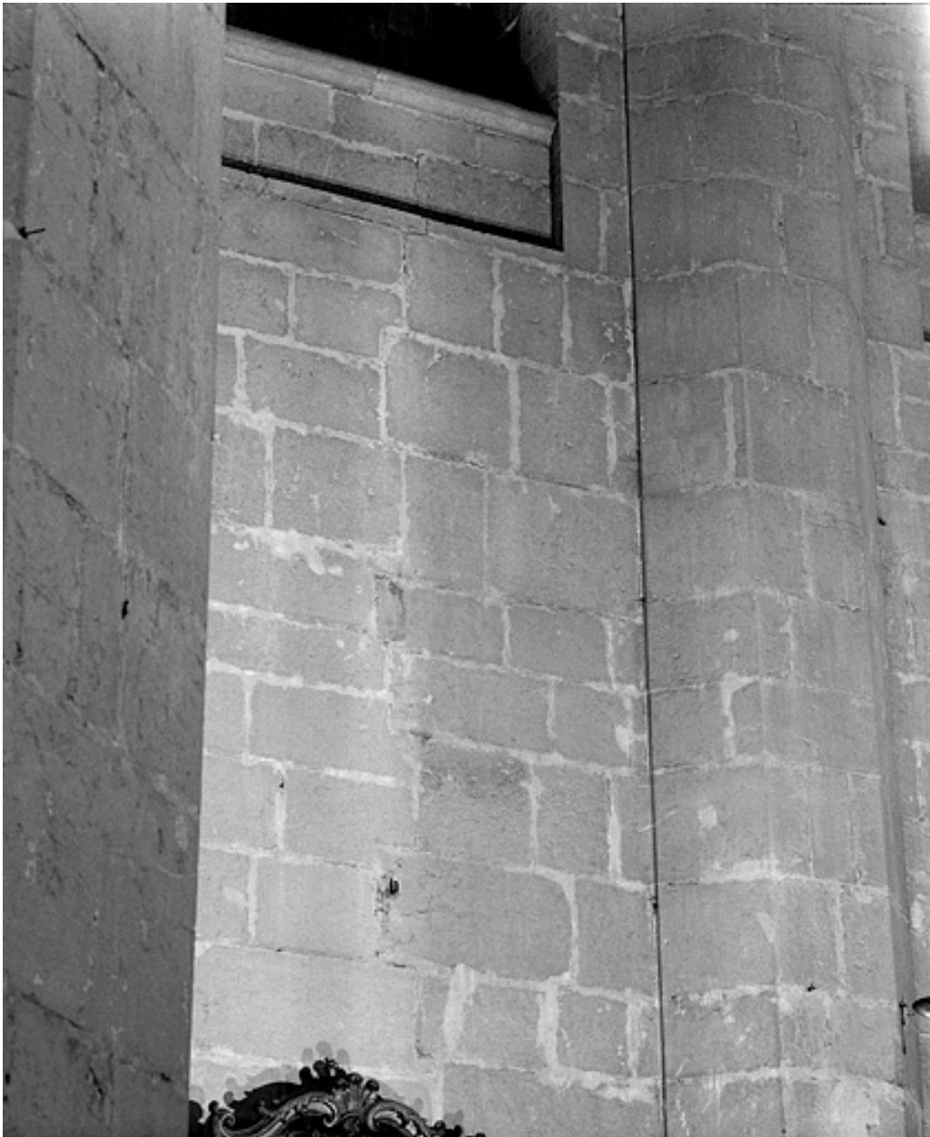
Détail du parement du collatéral nord : couture à hauteur de la sixième travée.
