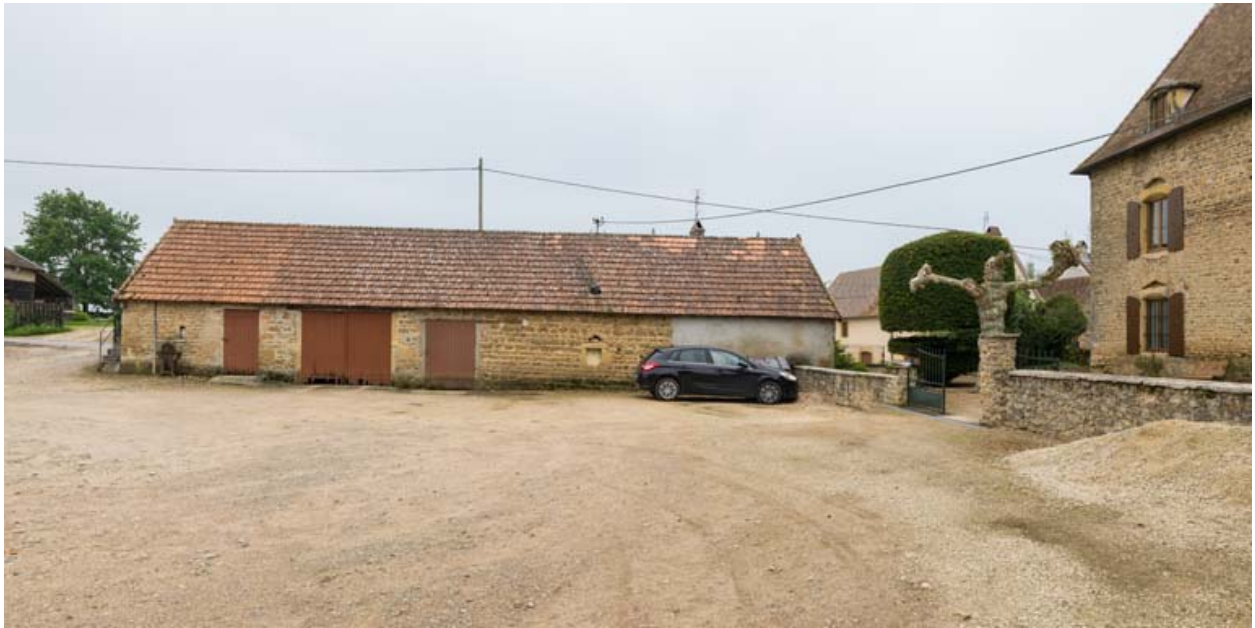
Bâtiment agricole : écurie, remise et bûcher.
