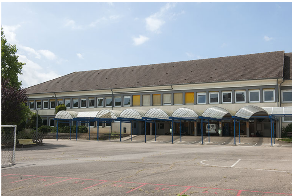
Façade du bâtiment depuis la cour.
