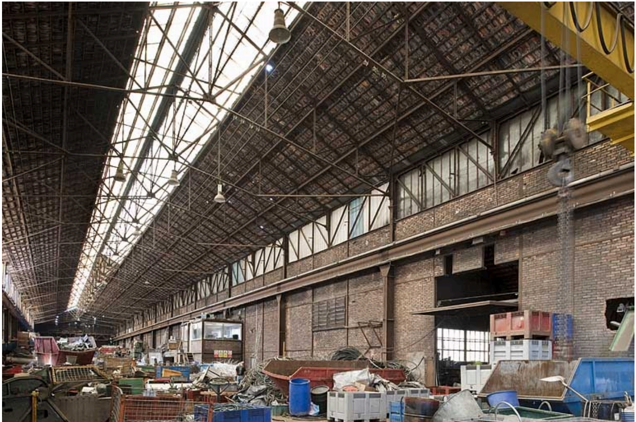
Atelier de laminage. Vue intérieure : charpente métallique et mur nord.
