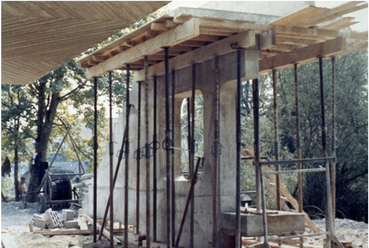
Vue de l'escalier lors du chantier, photographie ancienne, ca.1965, Archives privées.
