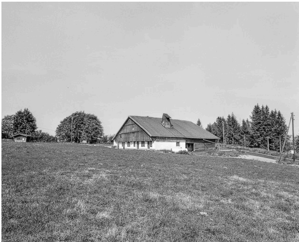
Ferme située au lieudit Pierre à Feu : façades antérieure et latérale droite.
