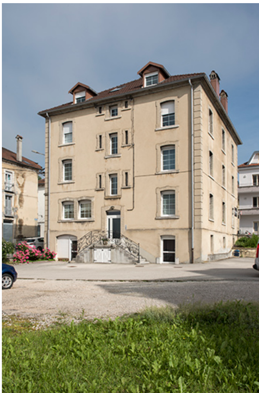
Façades sud (entrée, sur cour) et est.
