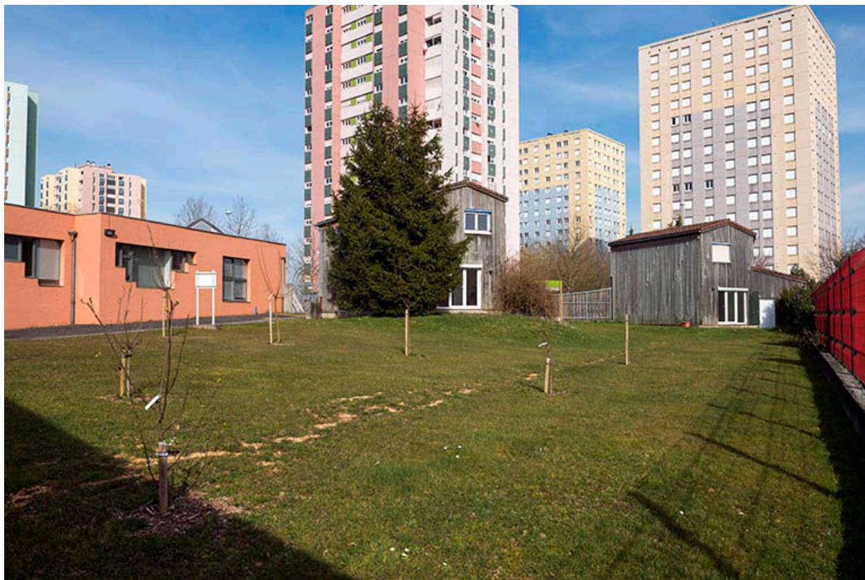
Façades postérieures des logements de fonction orientaux.
