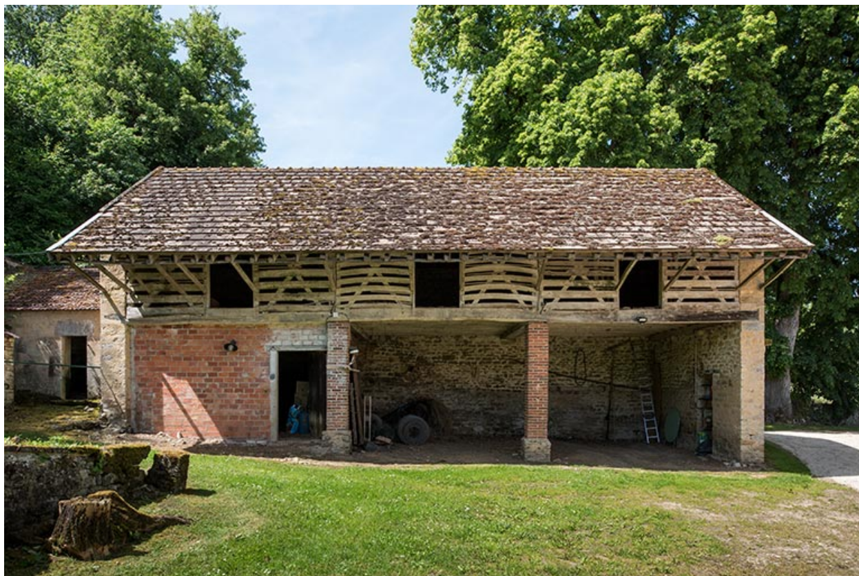
Le bâtiment du séchoir, de face.
