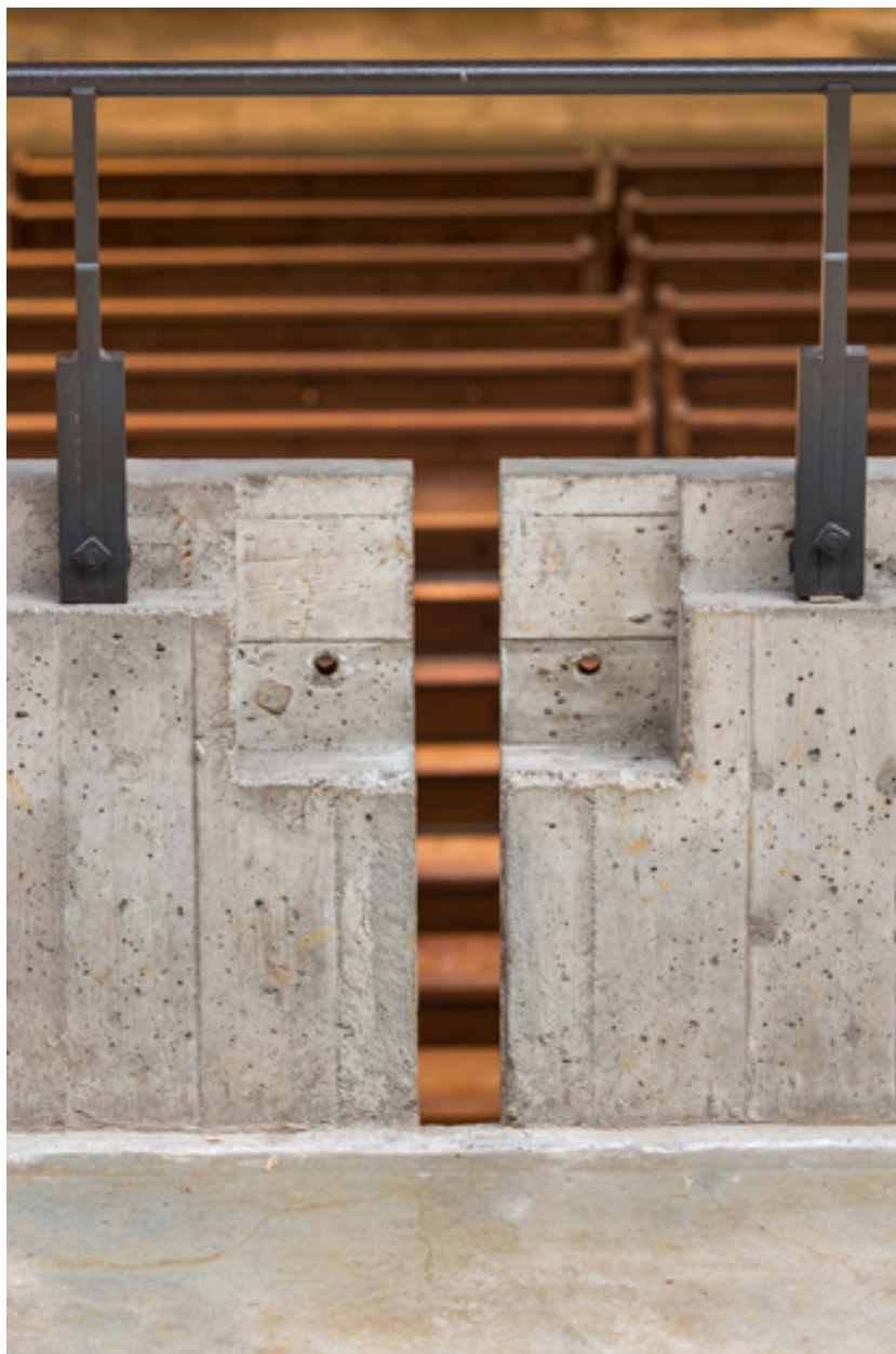
Garde-corps de la tribune sud. Détail.
