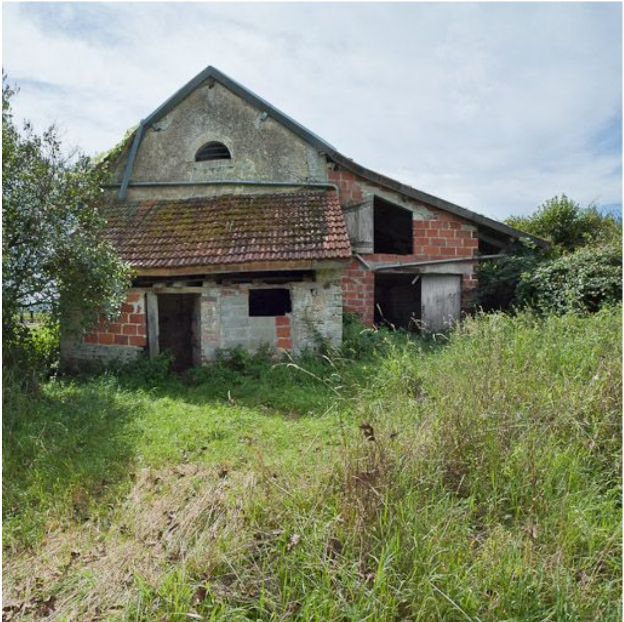
Vue latérale de la maison éclusière.
