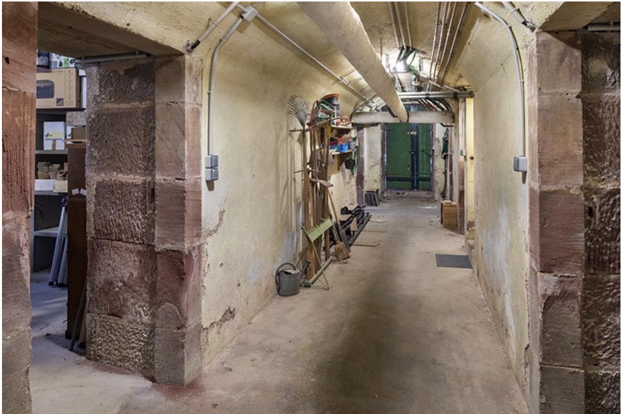
Couloir central du sous-sol, vue en direction de l'ouest.
