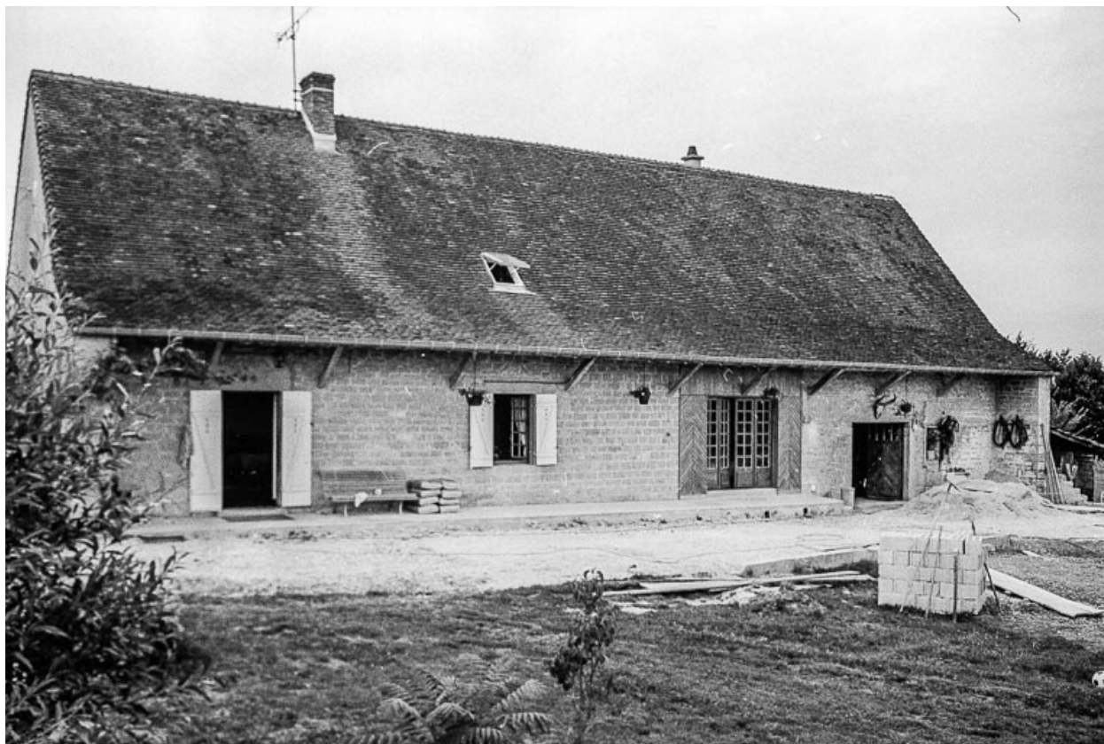
Ferme : façade antérieure.
