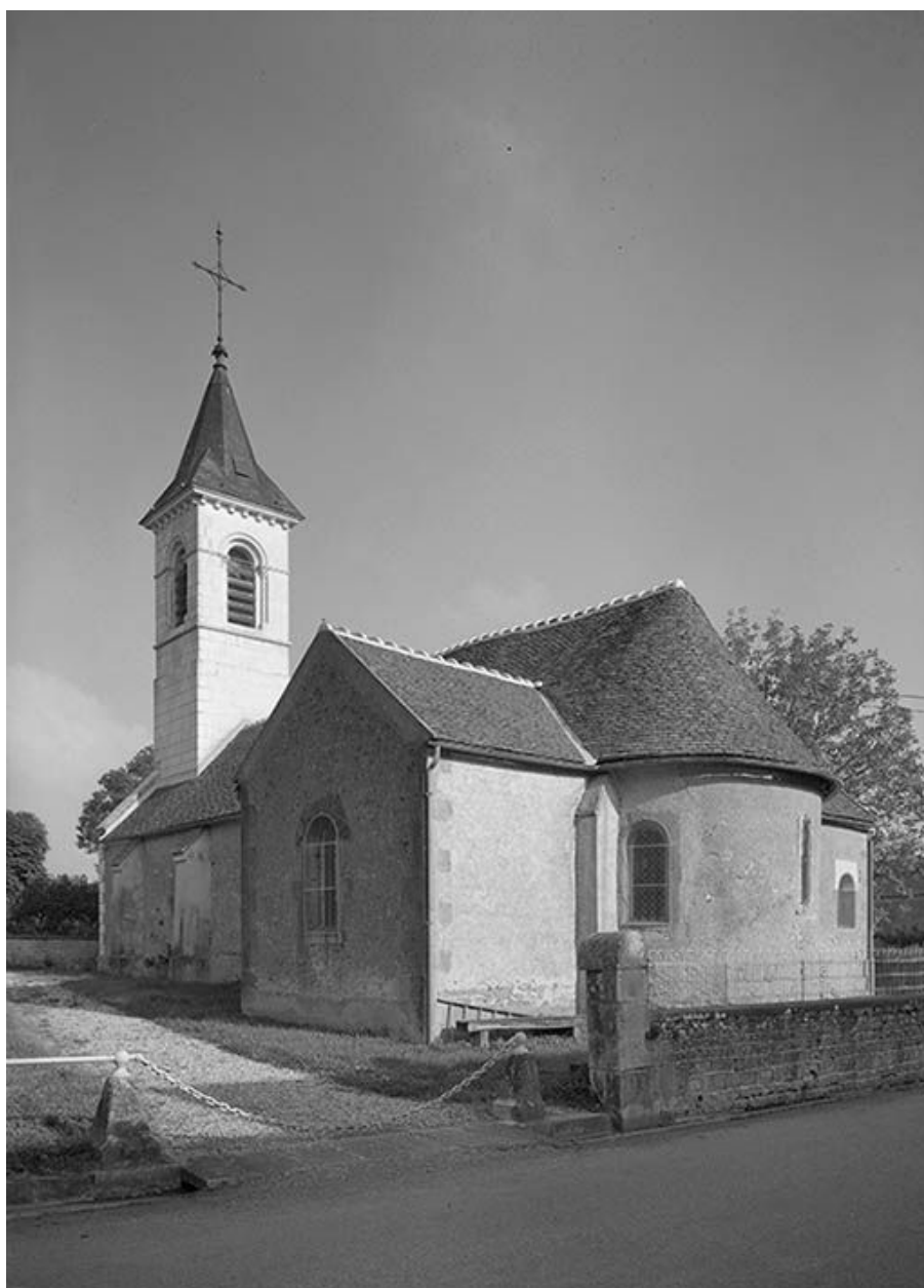
Elévation droite et abside
