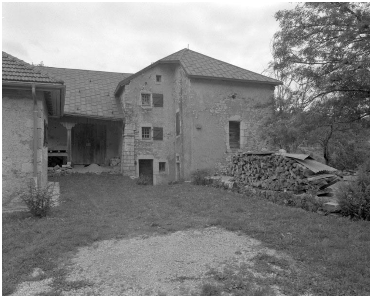
Façade sud-est, partie gauche du bâtiment.
