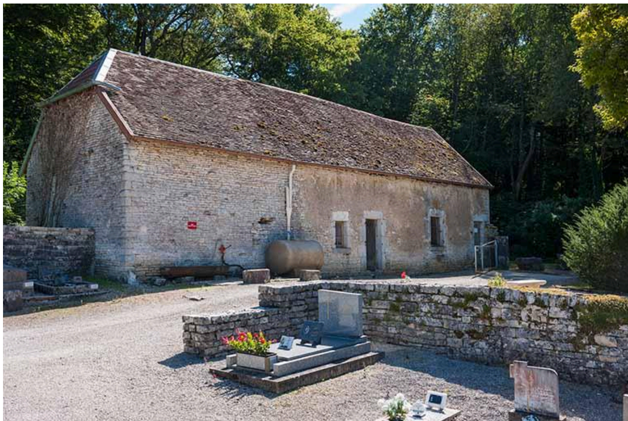
Ancienne ferme située au sud-ouest du cimetière
