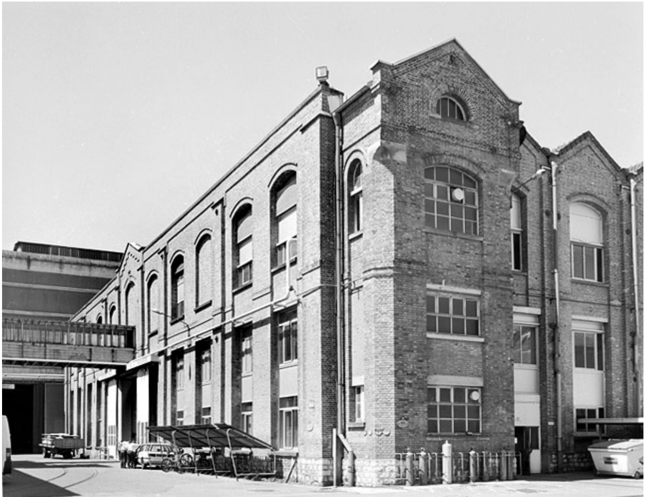
Façade sud de l'ancien atelier des grandes dynamos.
