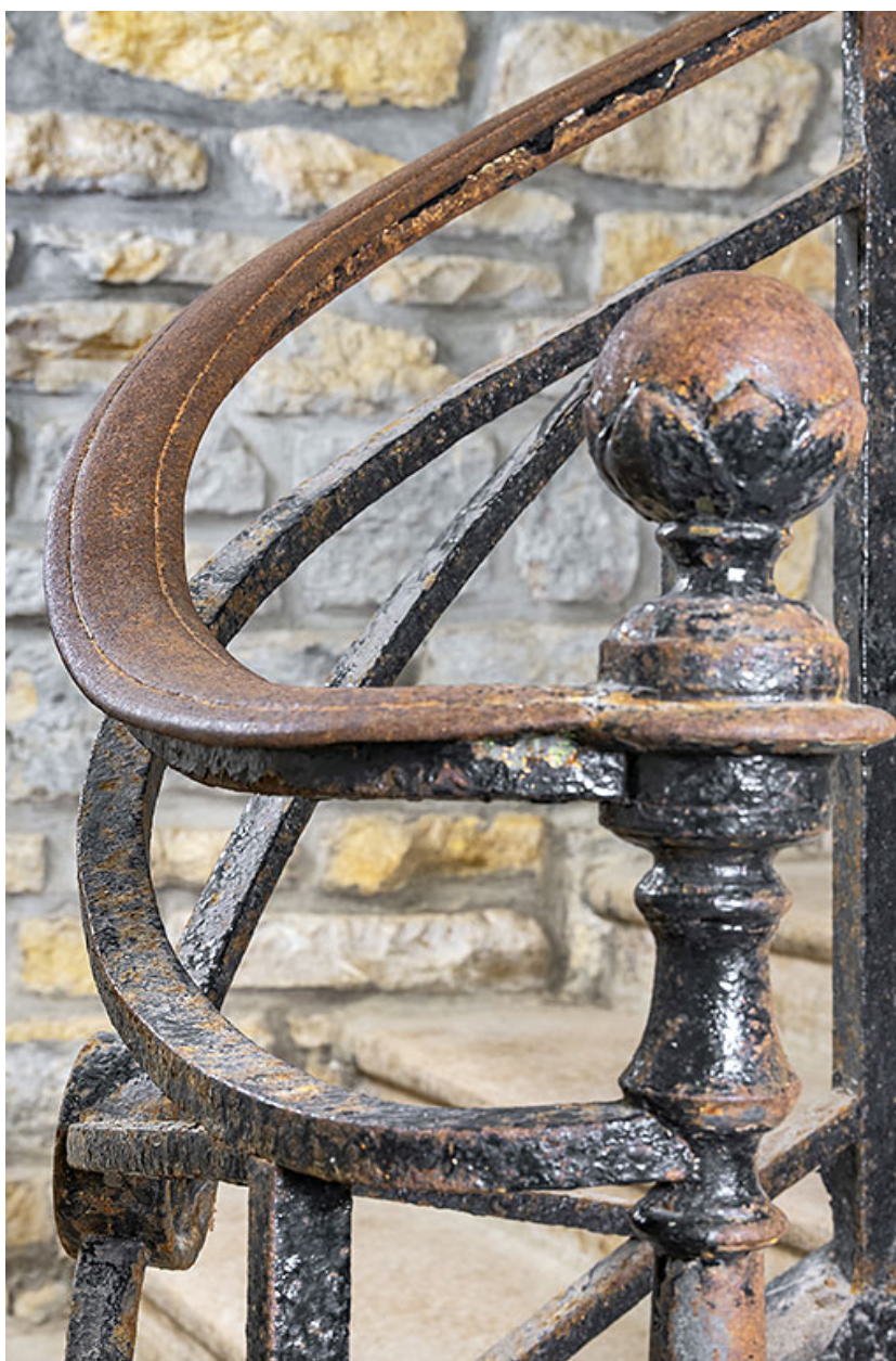
Détail du départ de la rampe et de la main courante.
