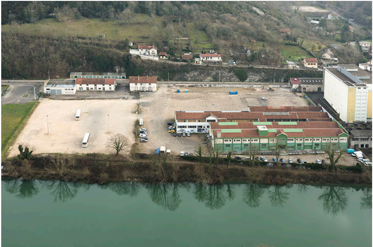
Etat en 2016. Usine B : vue plongeante sur les bâtiments de l'ancienne papeterie.
