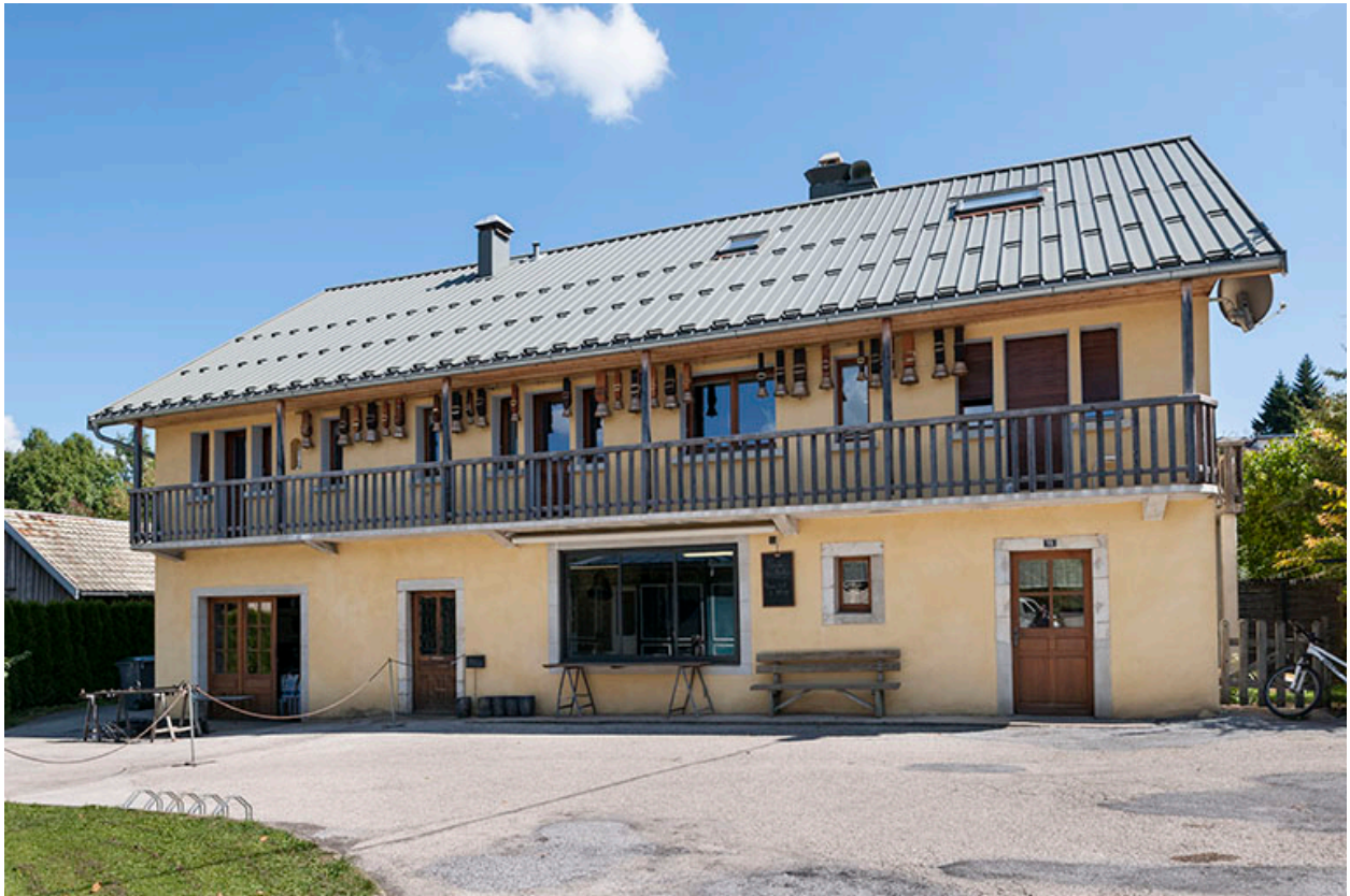
Façade ouest de l'atelier de fabrication.
