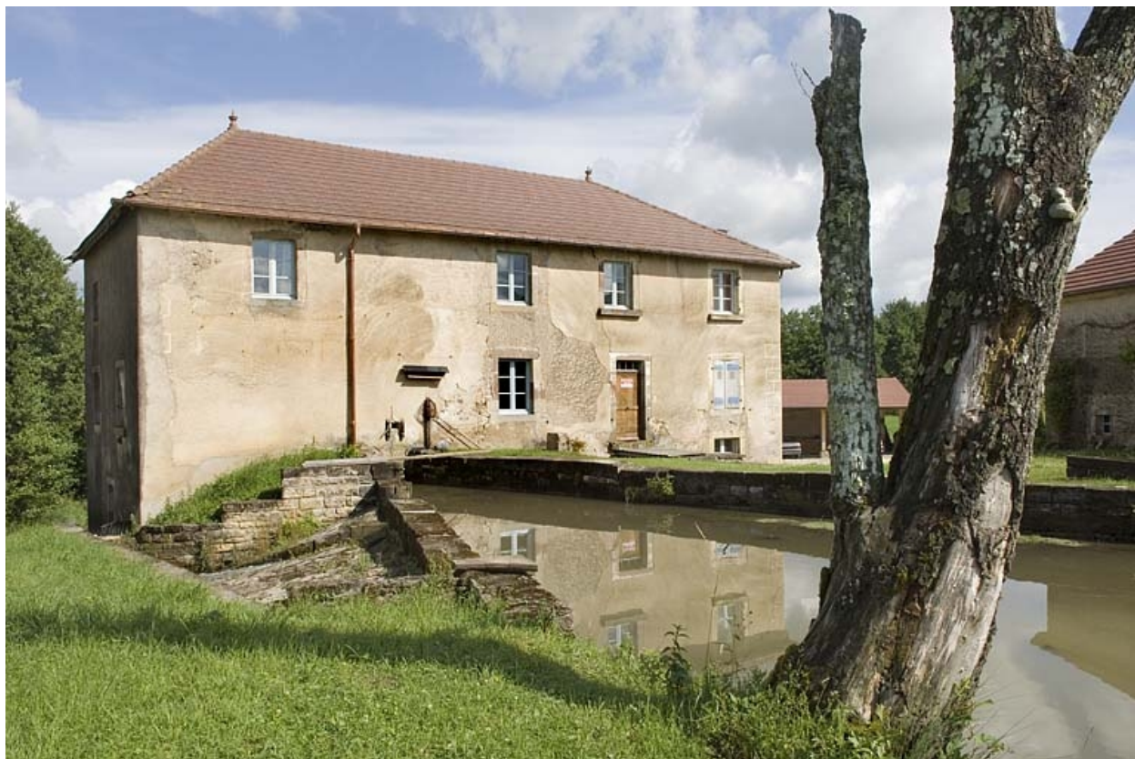
Façade sud du moulin.
