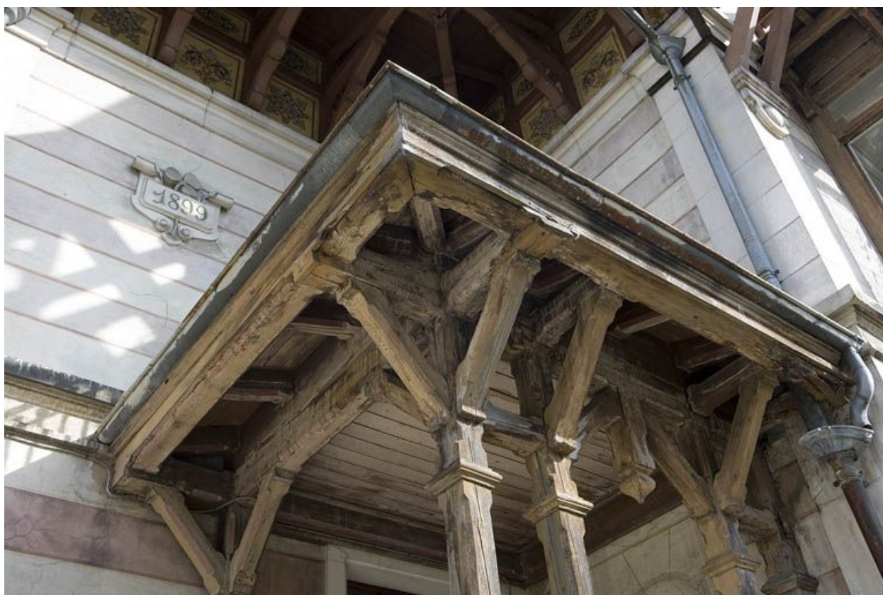
Elévation antérieure : charpente du porche.
