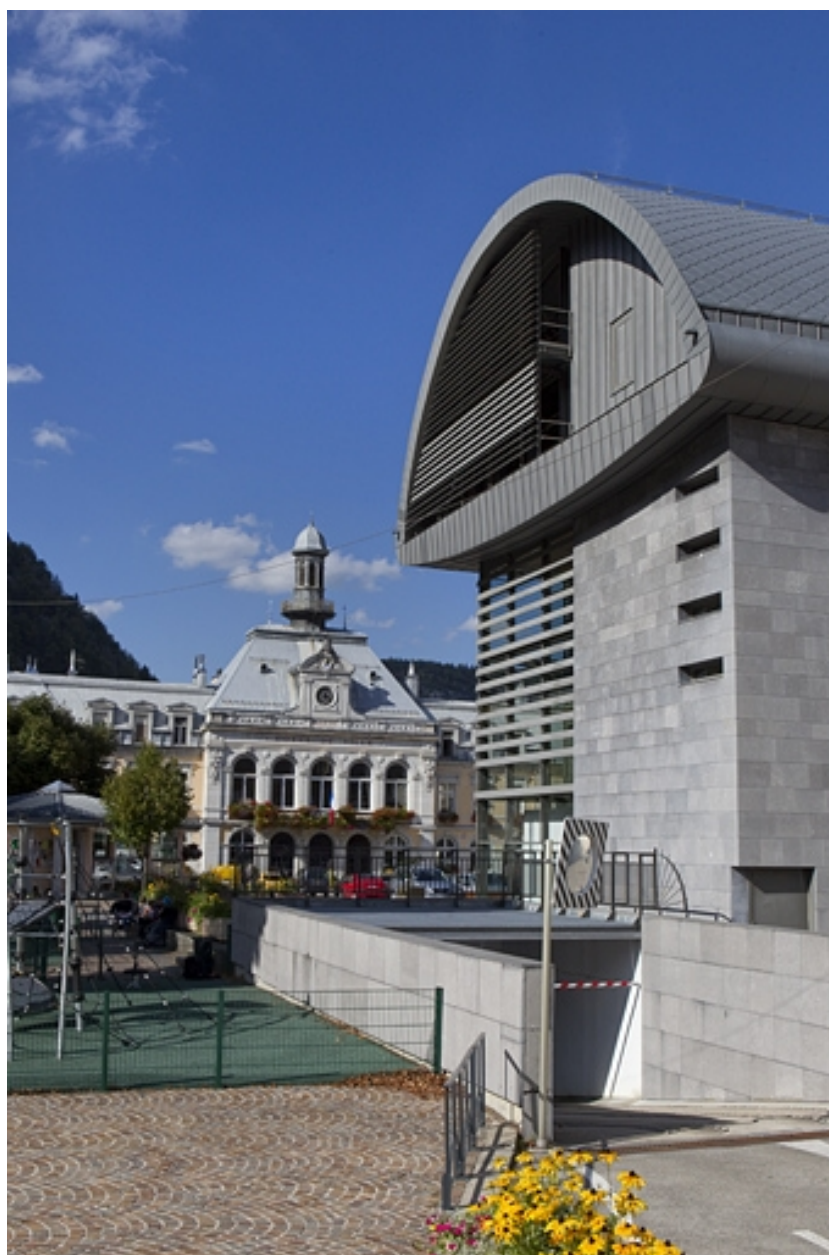
Façade latérale droite.
