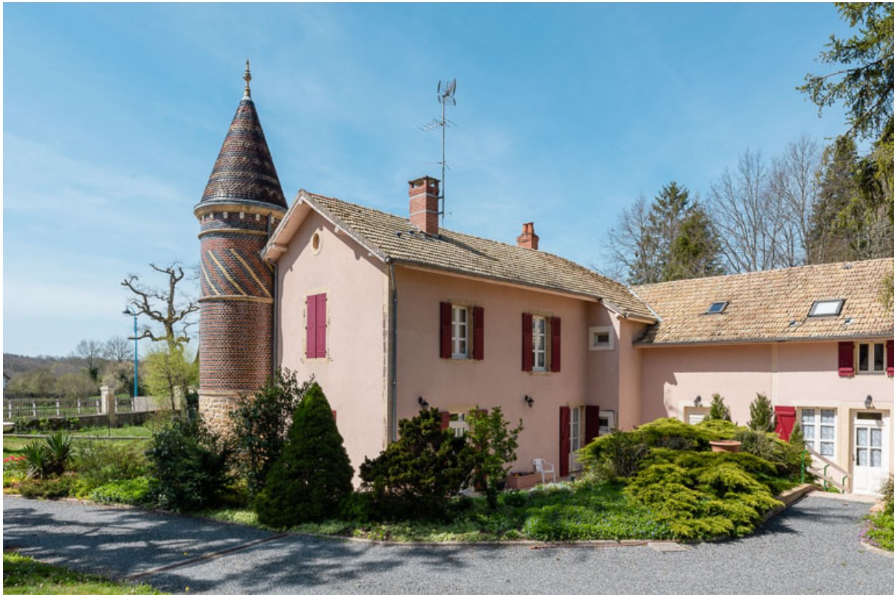
Façade nord-est, vue depuis l'est.
