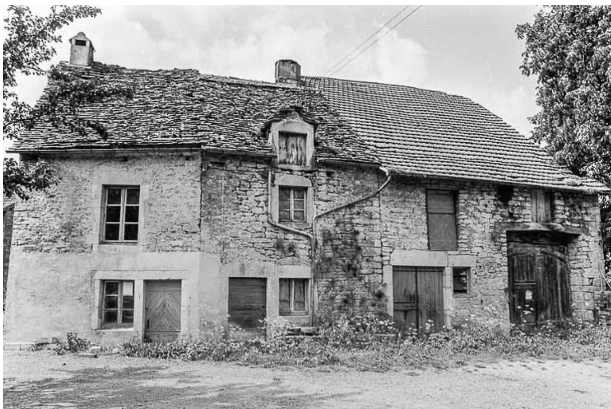
Ferme cadastrée 1951 E1 76 : façade antérieure.
