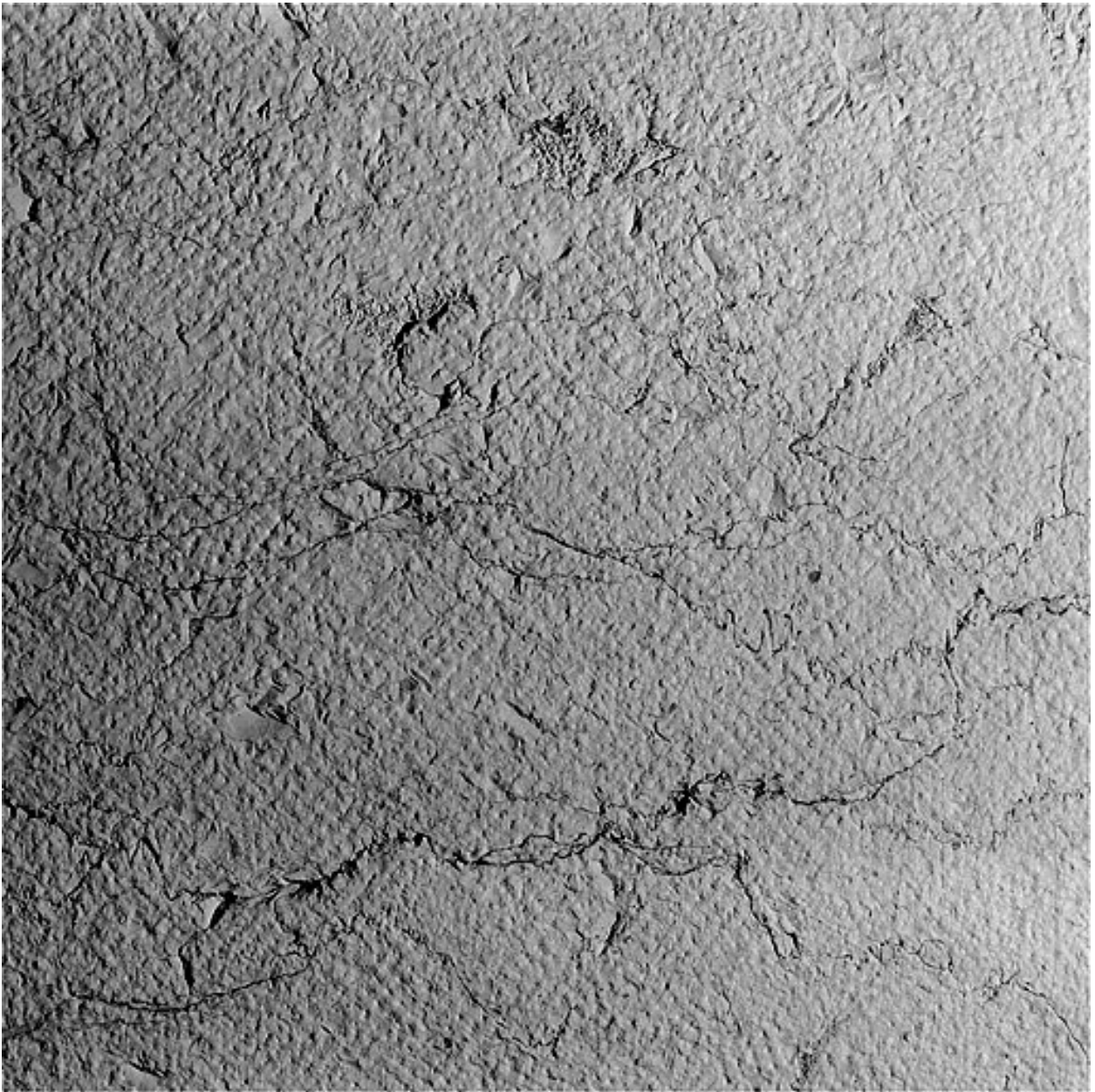
Détail du parement de la façade au sud (traces de boucharde).
