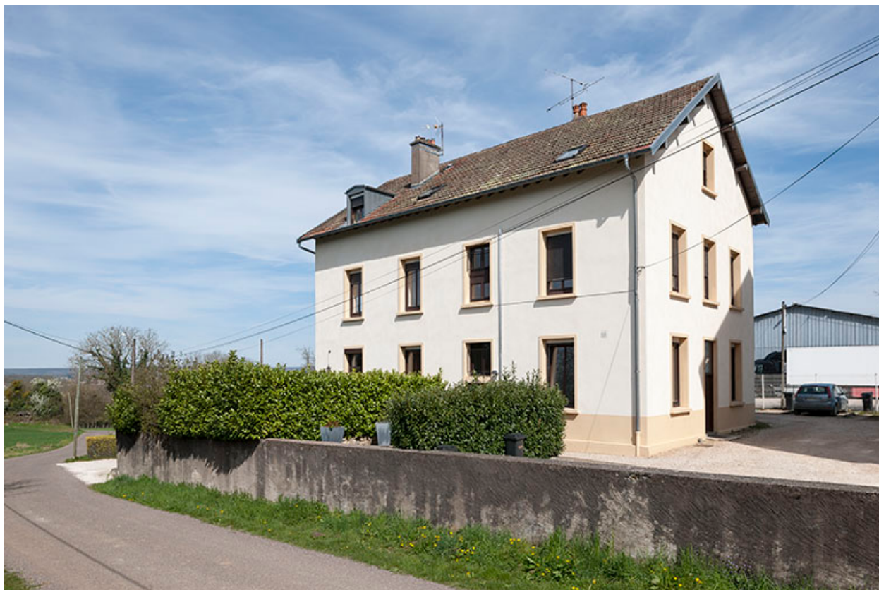
Logements (ancien bâtiment des contributions indirectes).
